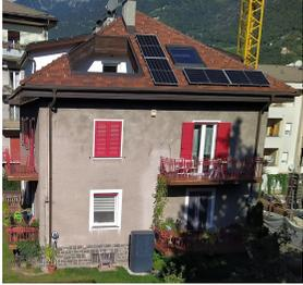
Außenwand 40 cm Lochziegel ohne Dämmung
